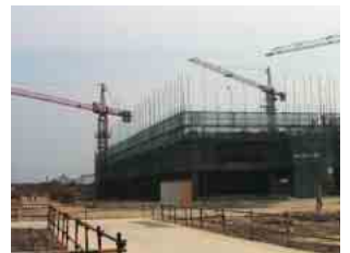
建設中の現場
