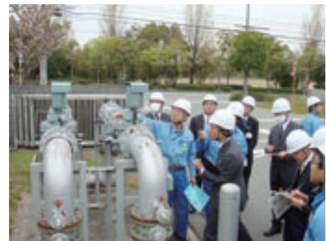
神戸サイトでの現場確認
