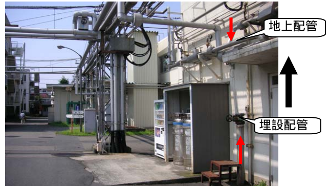
写真8-7 埋設配管から地上配管へ
