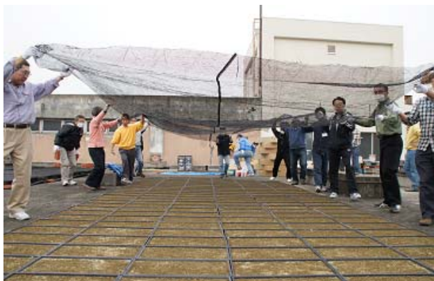
写真8-10 苔種苗を基材に蒔き、それを屋上に設置した畝に置いて固定し、300m 2 の苔の畑とし、最後にネットをかけて作業を無事終了
