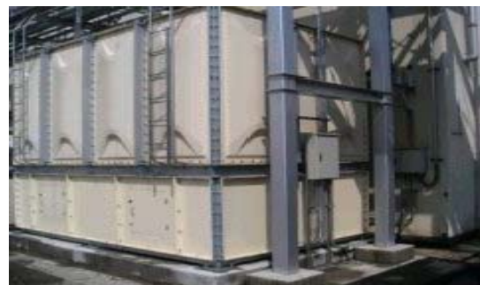
写真8-8 土壌汚染の浄化水の貯水タンク
