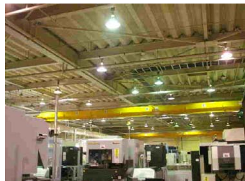
写真 8-5 水銀灯から LED 照明灯へ
