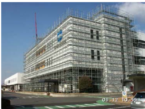
写真 8-4 1号棟壁の断熱塗装工事
