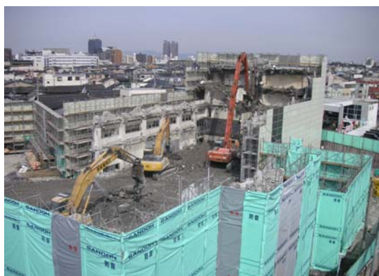
写真6-7 東ブロック解体工事
