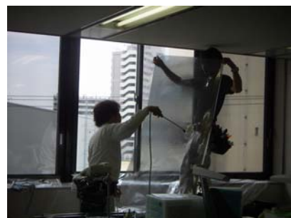
写真6-1 遮熱フィルム施工
