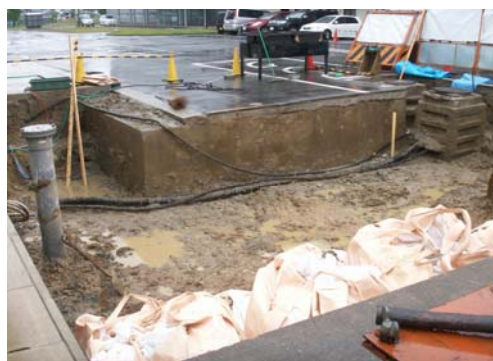
写真6-7 浄化工場の基礎工事
