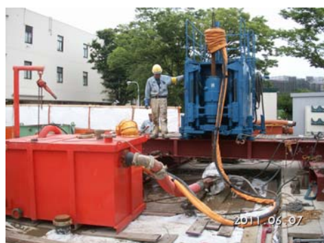
写真6-8 浄化のための酸化剤注入工事
