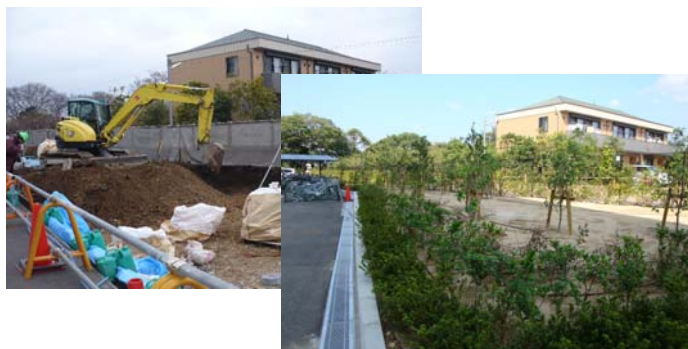
写真6-7 08年工事後の植栽（東側）
